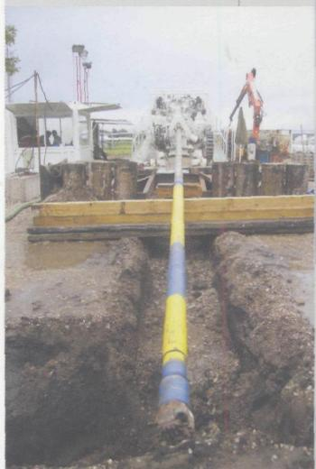
Отсутствие повреждений морской акватории – один из основных факторов выбора технологии ГНБ для строительства перехода через пролив Босфор Восточный.
